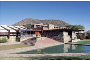
1A1-WFL-TW-G2 / Taliesin West
