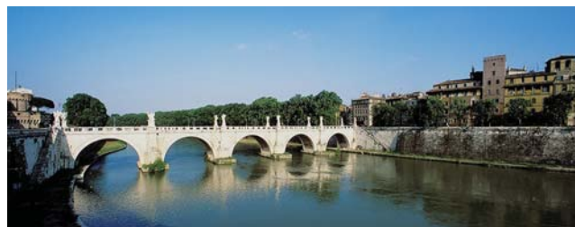
1A3-R-R-PAD-A1 / Ponte Sant'Angelo
