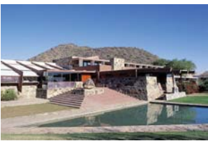
1A1-WFL-TW-G2 / Taliesin West
